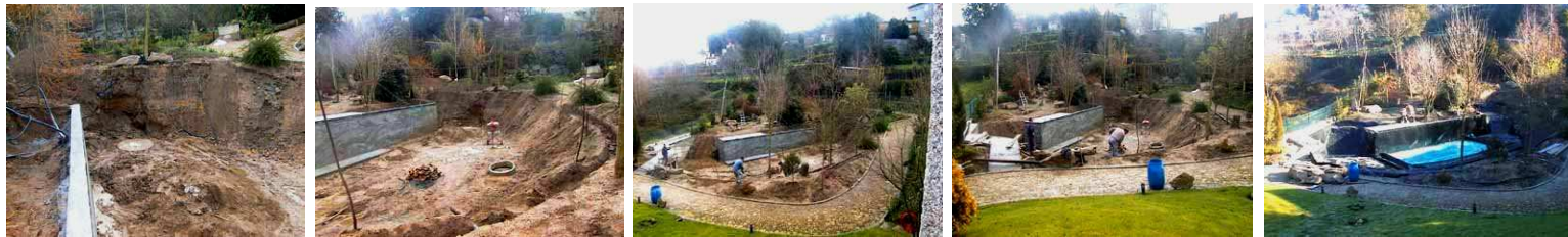
Fases da construção duma piscina natural que podera ser executada em 30 a 45 dias
